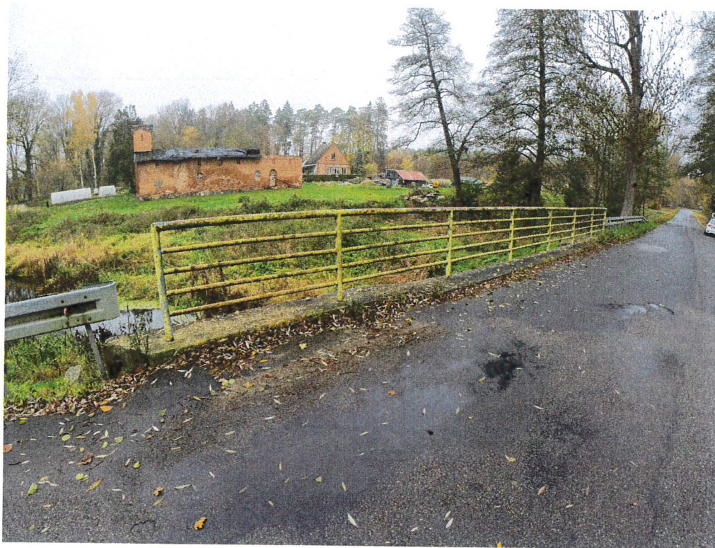
Fot. 2. Widok na balustradę
