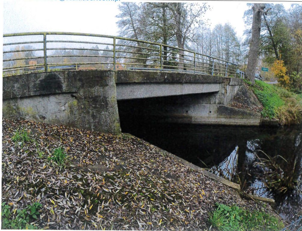
Fot. 3. Widok boczny na obiekt
